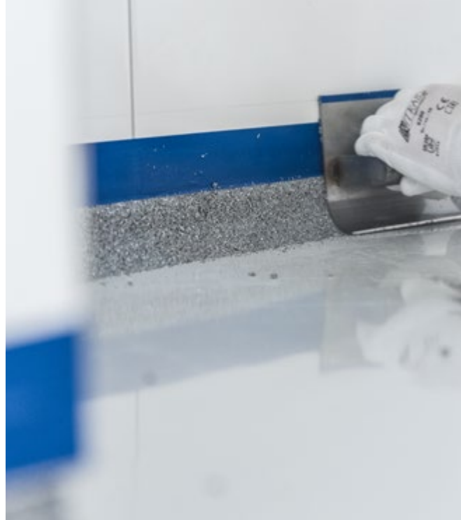
Ausbildung der Hohlkehle für einen fugenlosen und sauberen Abschluss.
